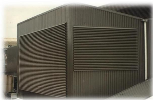
Persiennes fixes filantes sans limite de dimensions peuvent être montées en façade de bâtiment, en amont de silencieux ou encore sur des lanterneaux d'aération.
