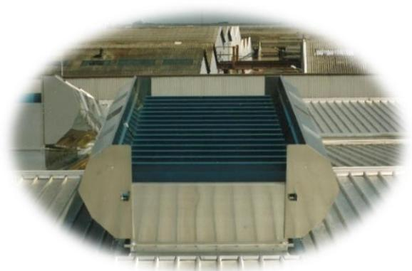
Aérateurs à lames en aluminium, positionnés suivant rampant dans les locaux à forte pollution (chaleur et fumées). Ce type d'aérateur avec des performances aérauliques élevées même par temps de pluie, est généralement positionné à l'aplomb des sources d'émission.
